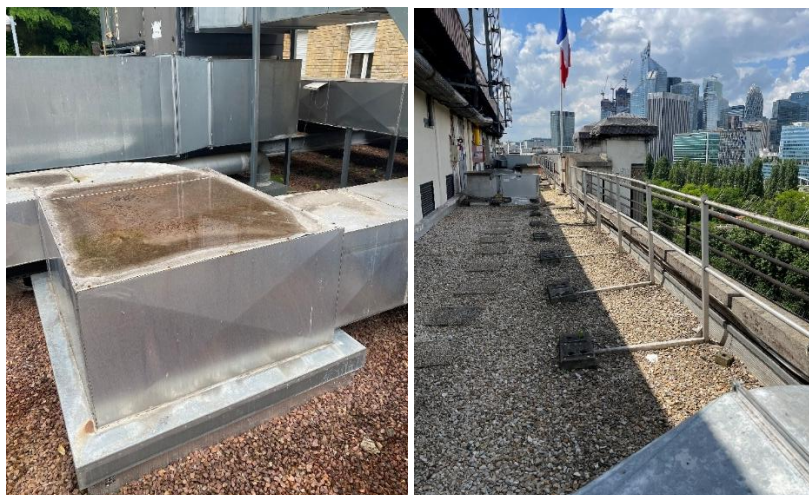
Figure 8 : Toits plats entretenus (2024) (source : Agence régionale de déoustication – ARD)
