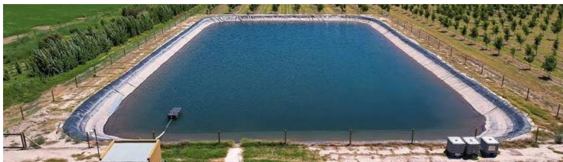
Figure 2 : Bassin de rétention d'eau extérieur (source : SMA BTP - www.smabtp.fr )
