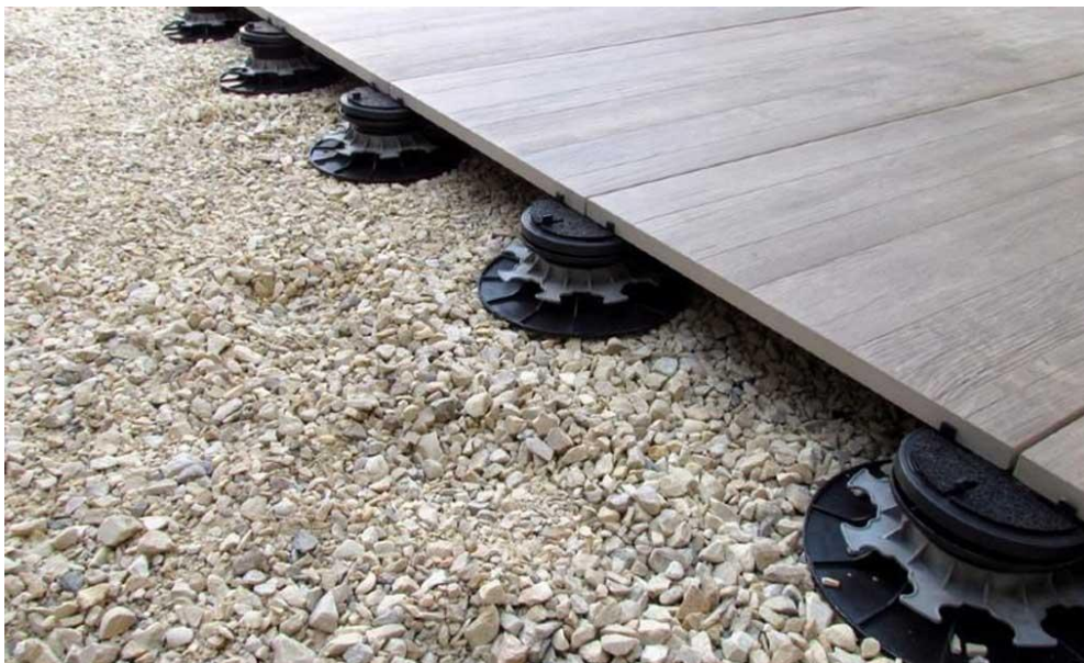
Figure 10 : Terrasse sur plots (source : Pavebeton : https://www.pavebeton.fr/terrasse-dalles-sur-plots/ )
