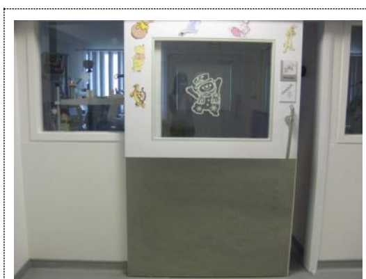
Photo n°17 : porte d'une chambre
