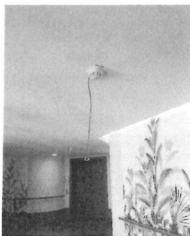
Étage 2 - couloir de circulation
