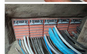
Etanchéité des passages de câbles
