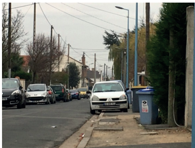
Figure 6 : marchabilité limitée par des trottoirs et mobiliers urbains usagés, amplifiée par du stationnement sauvage
