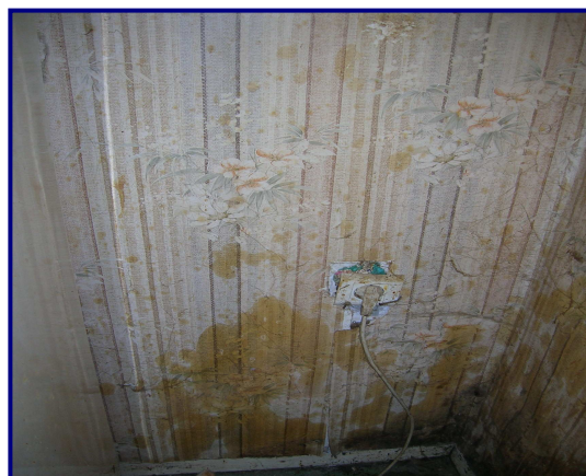
Electricité dangereuse et humidité
