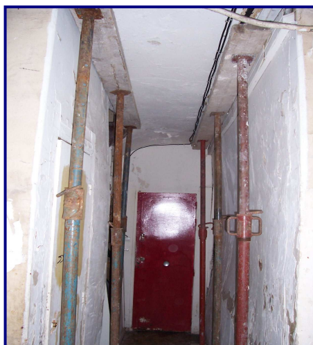
Logement en situation de Péril
