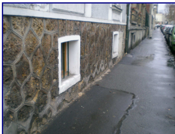
Fenêtres d'un local en sous-sol : Impropres à l'habitation
